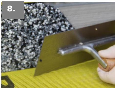
8. ...und anschließend unter leicht schiebenden Bewegungen mit etwas Anpressdruck an dem Sockel senkrecht angebracht.
