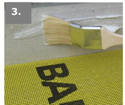
3. Das auftragen erfolgt optimalerweise mit einem Flachpinsel in einer Schichtstärke von 1-2mm vollflächig. Das Einbetten mit den Dekor Drain Steinen welche sich **im ersten Eimer** befinden, sollte innerhalb 30 Minuten erfolgen.
