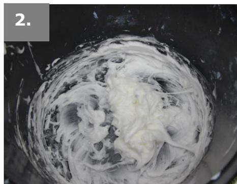
2. Dies wird zu einer standfesten weichen Paste gerührt (eine Art wie verdickte Schlagsahne). Mischungsverhältnis und Menge für z.B. **für 4,0m Sockel:**
